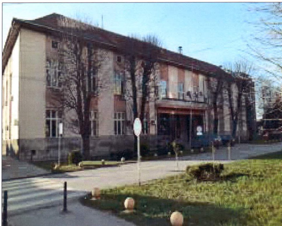
Слика 2. Мерно место бр.1. Ковин - зграда општине
