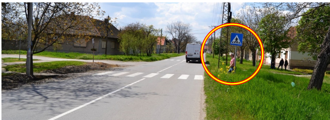
Слика 3.1.19. Насеље Гај, државни пут IIА реда, ознаке пута 134, пешачки прелаз без саобраћајног знака за возаче из супротног смера, растиње поред коловоза и косина насипа делимично ометају прегледност. Локација смртног страдања пешака.
