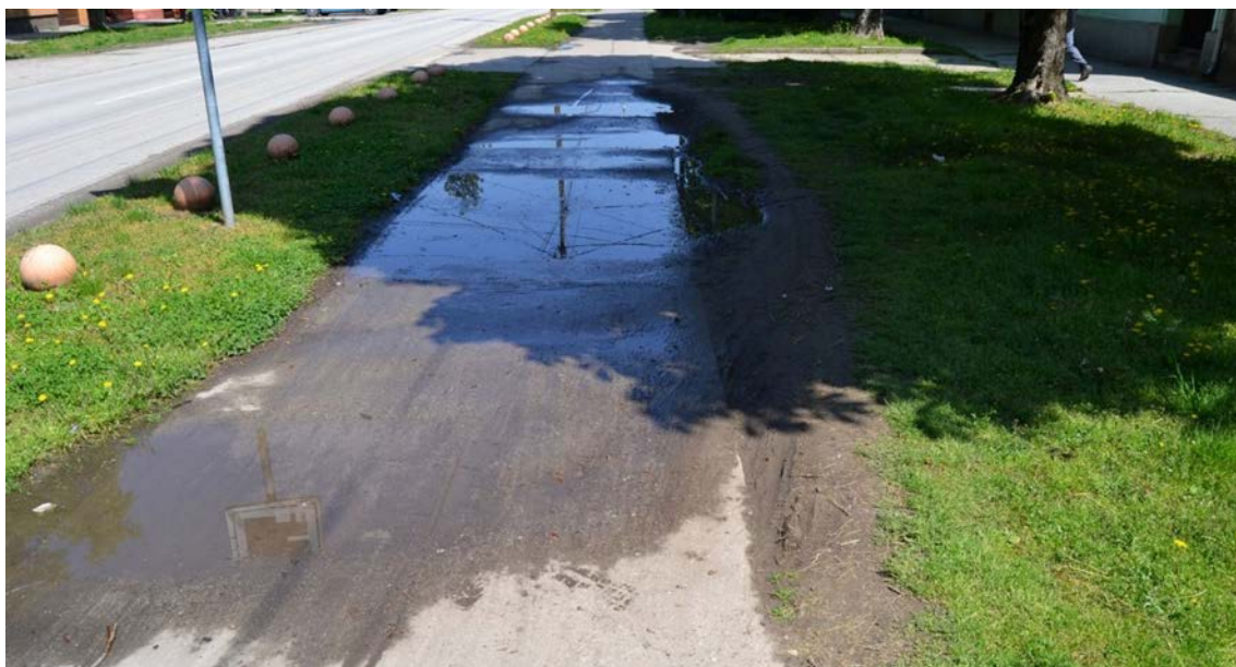
Слика 3.1.24. Центар Ковина, на многим местима се, због неадекватне дренаже, вода задржава на пешачким и бициклистичким стазама
