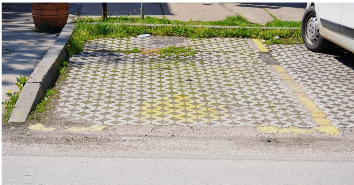
Слика 3.1.14. Центар Ковина, Улица ЈНА, непрепознатљиве ознаке на паркинг-месту
