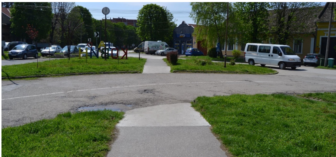
Слика 3.1.16. Центар Ковина, Улице ЈНА – Цара Лазара: пешачка стаза води пешаке право на коловоз без обележеног пешачког прелаза
