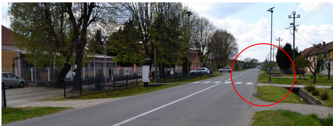
Слика 3.1.23. Насеље Дубовац, зона ОШ „Петар Кожић“, државни пут IIА реда, ознаке пута 134, пешачки прелаз без саобраћајних знакова
