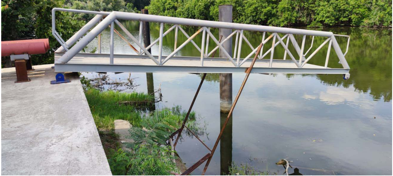
Слика 9. Пристан – 4 шипа за речно претакалиште за запаљиве течности
