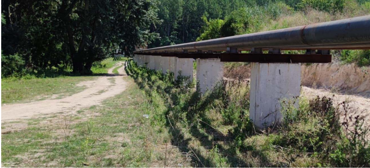
Слика 10. Припадајући надземни цевовод за запаљиве течности
