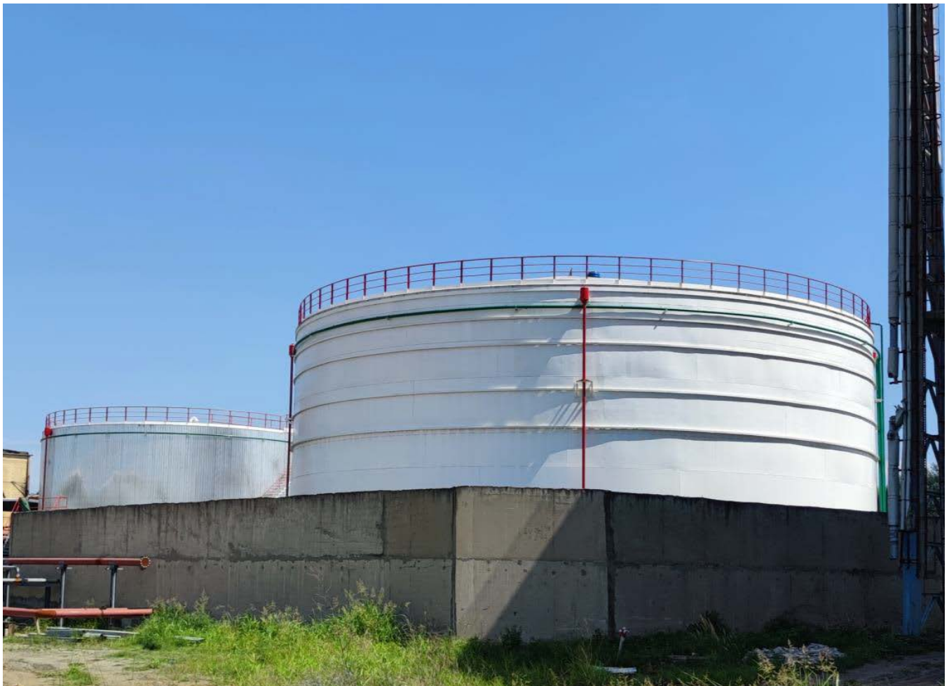
Слика 2. Надземни складишни резервоар – Р2 запремине 3200м 3 са припадајућом танкваном
