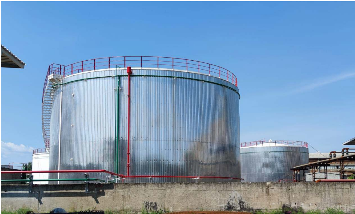
Слика 1. Надземни складишни резервоар – Р1 запремине 8000м 3 са припадајућом танкваном
